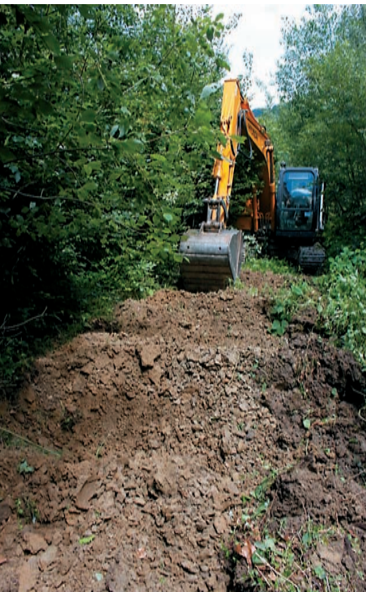
Рис. 7. Процесс рекультивации трелевочного волока
