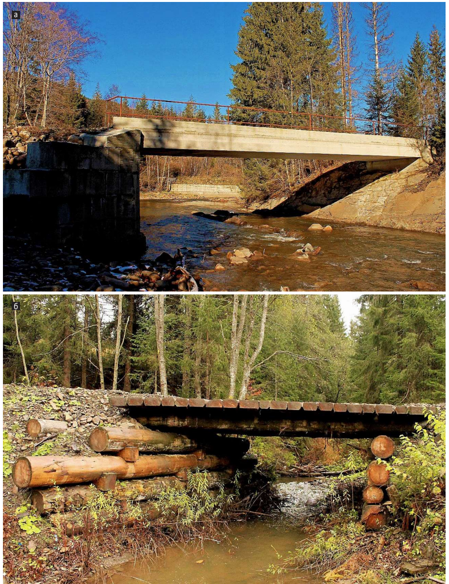
Рис. 5. Мости на лісових дорогах різних типів а) залізобетонний на дорозі II типу; б) дерев'яний на лісовому проїзді
