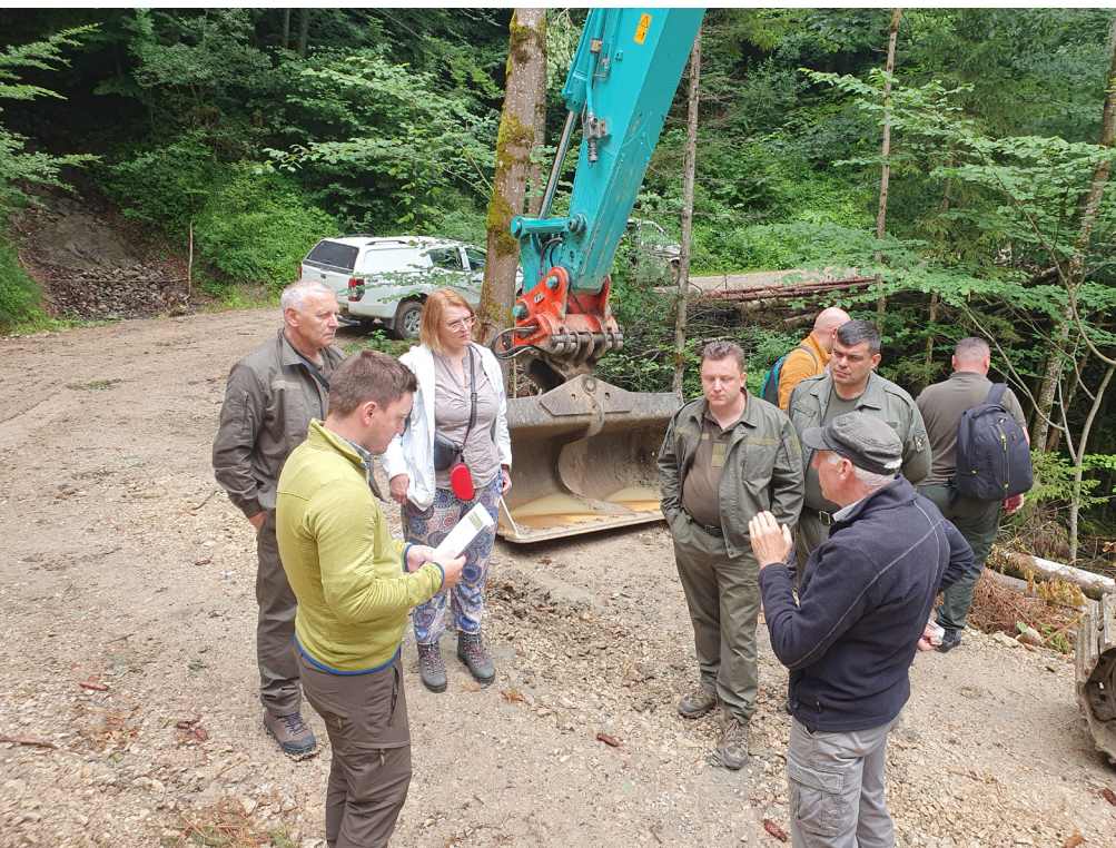
Рис. 9. Момент будівництва лісової дороги
